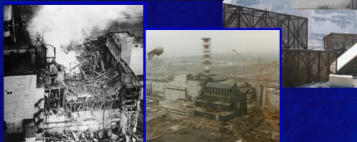
Reaktor trzy dni po eksplozji oraz budowa sarkofagu.
